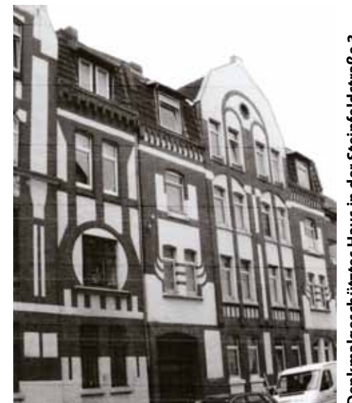
Denkmalgeschütztes Haus in der Steinfeldstraße 3
