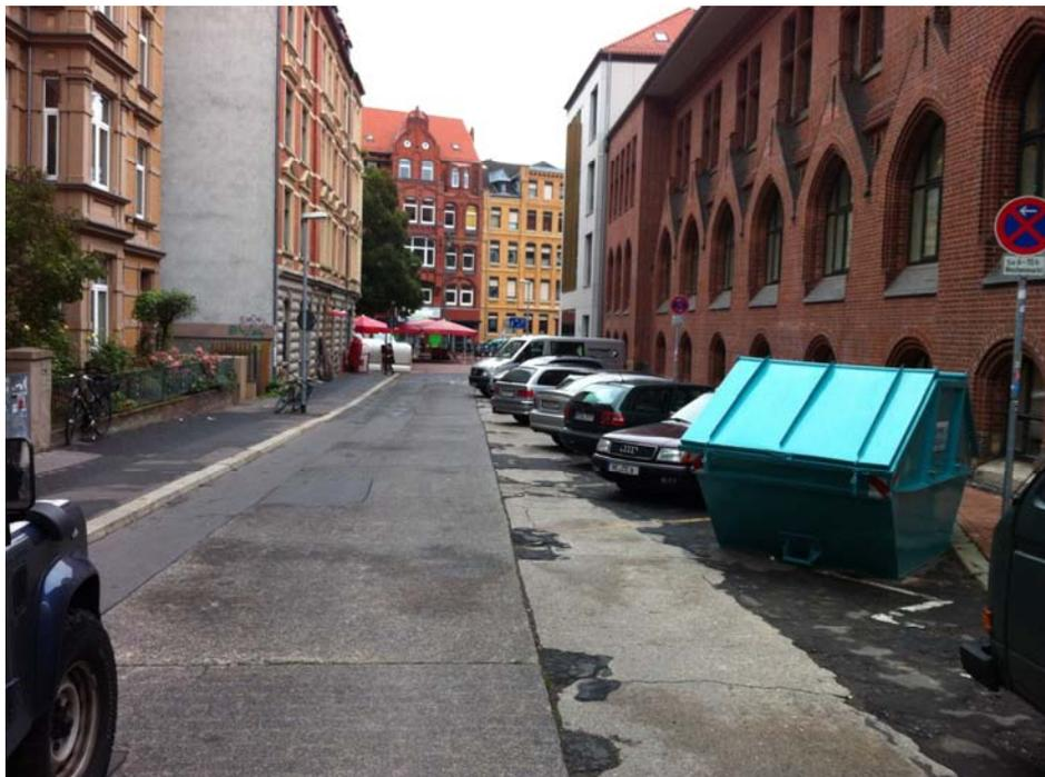
**Vorhanden**      Fahrbahn: **Beton mit Asphaltaufbrüchen**
