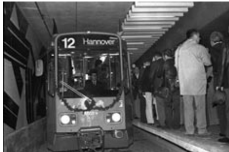
Eröffnung des ersten Tunnelabschnitts
